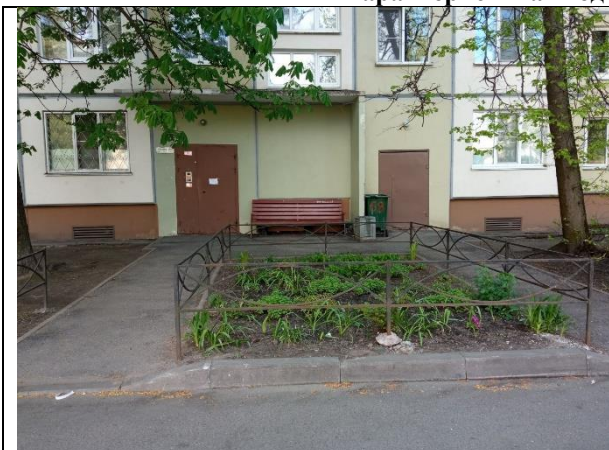
Фото 5. Общий вход со двора
