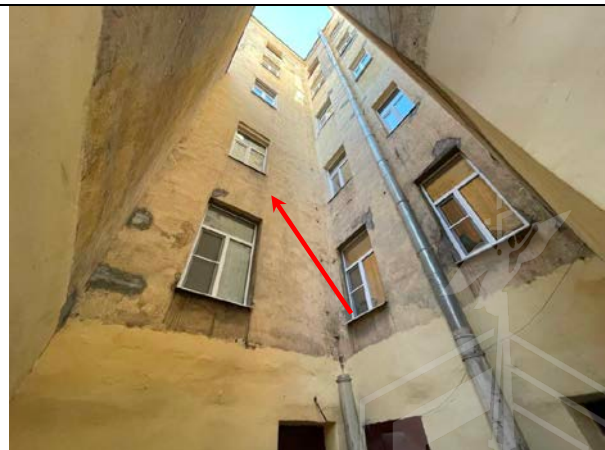
Фото 20. Вид здания расположения Объекта оценки
