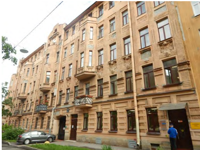
Фото №3 (вход в ч.п.32 пом.1-Н)
