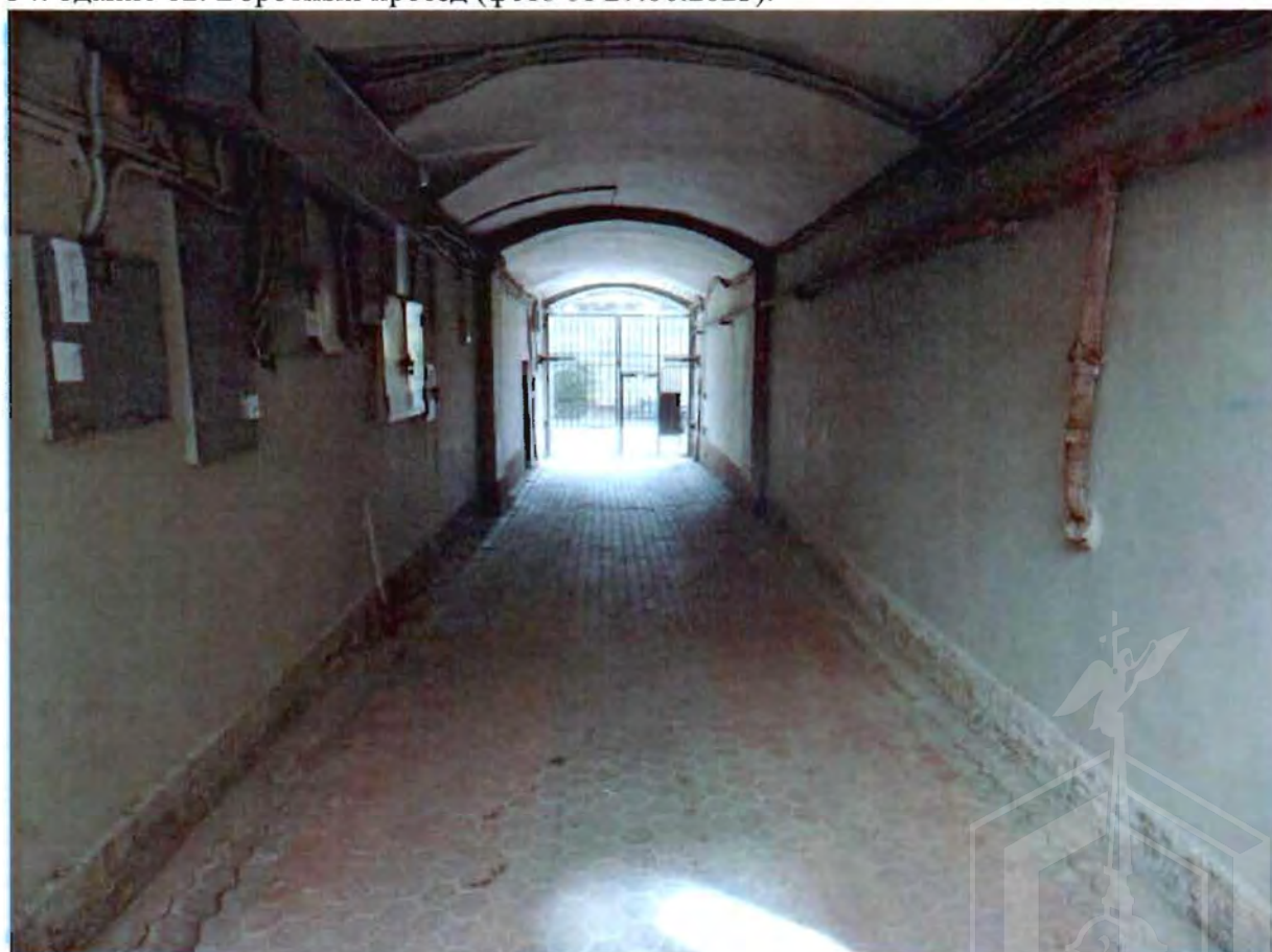
34. Здание 12. Воротный проезд (фото от 27.06.2023).
