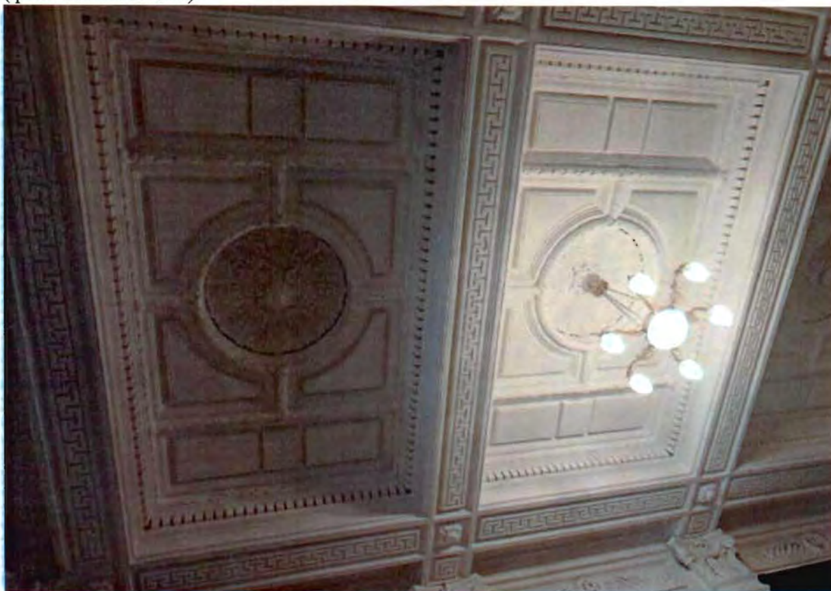
29. Здание 12. Оформление потолка вестибюля парадной лестницы 1ЛК (фото от 27.06.2023).
