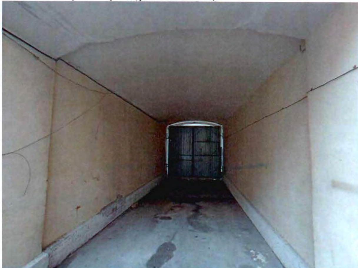
33. Здание 14. Воротный проезд (фото от 24.03.2023).
