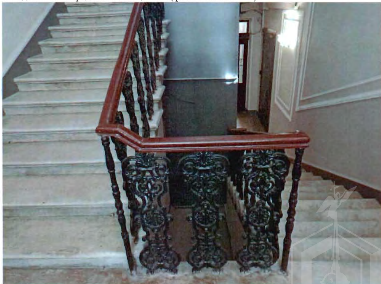
26. Здание 12. Парадная лестница 1ЛК (фото от 27.06.2023).
