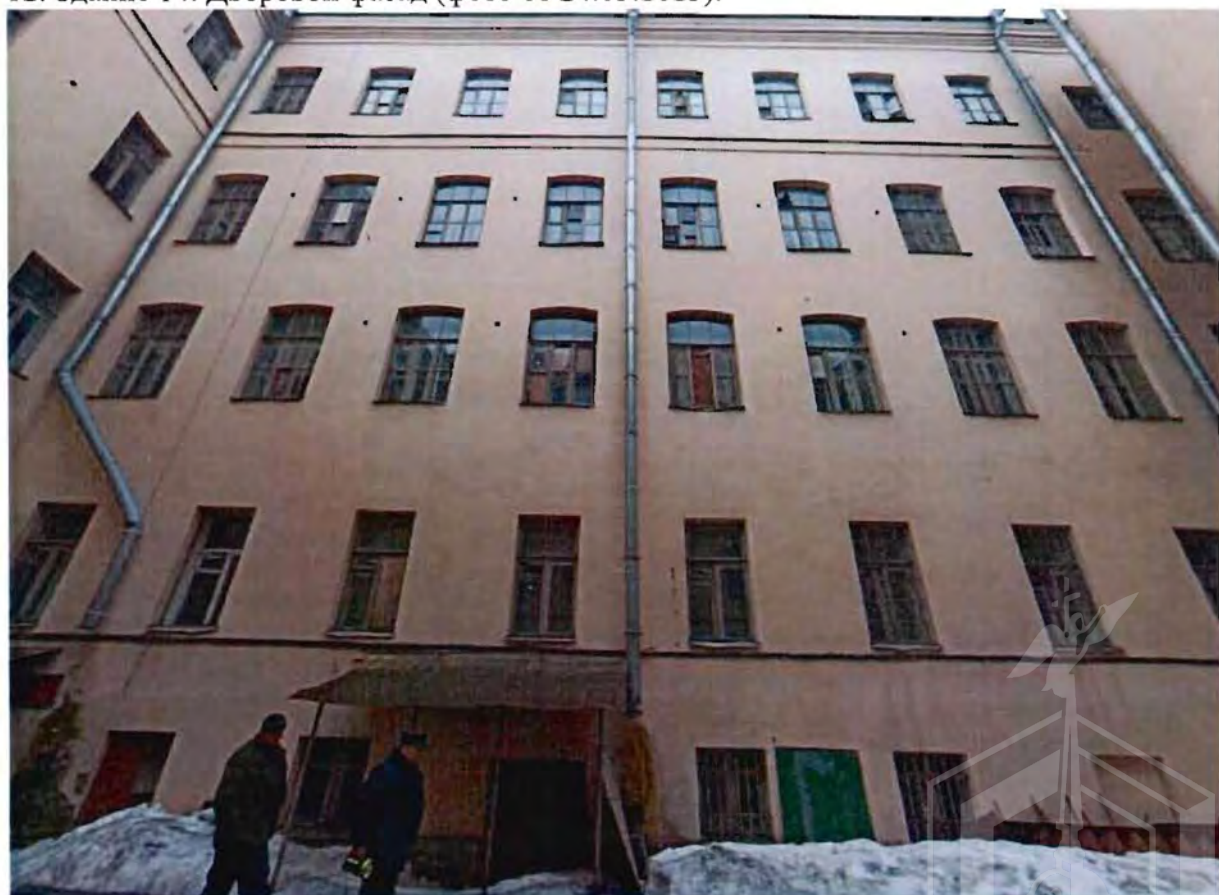
12. Здание 14. Дворовой фасад (фото от 24.03.2023).
