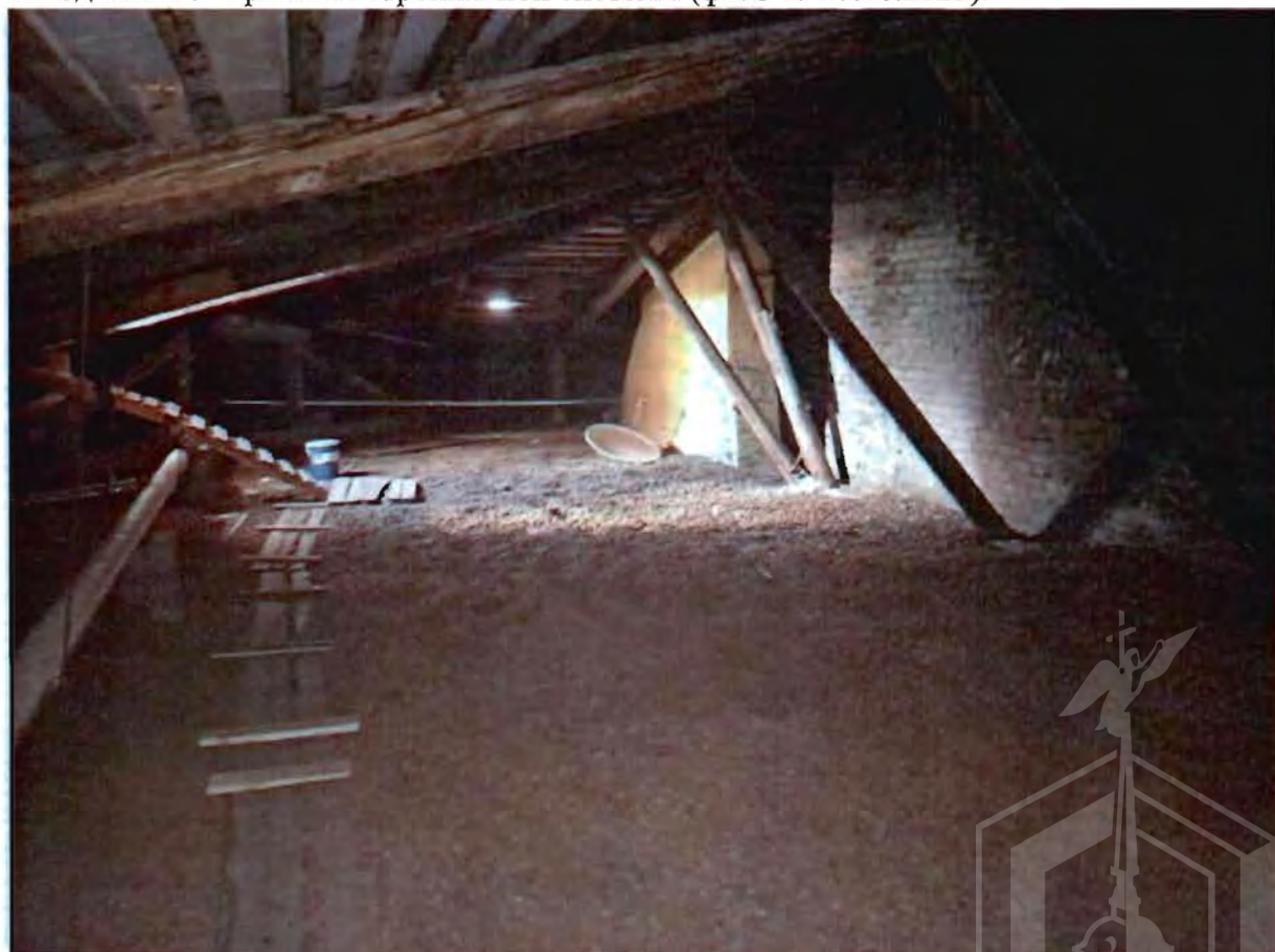
38. Здание 14. Фрагмент стропильной системы (фото от 27.06.2023).
