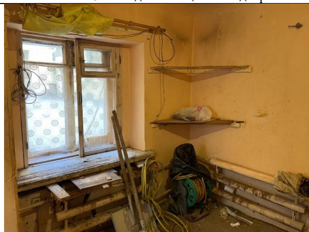
Фото № 10 – Внутреннее состояние помещения
