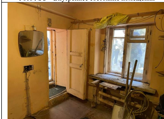
Фото № 11 – Внутреннее состояние помещения
