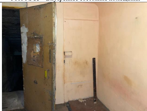
Фото № 12 – Внутреннее состояние помещения
