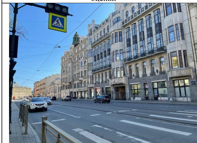
Фото № 3 – Подъездные пути
