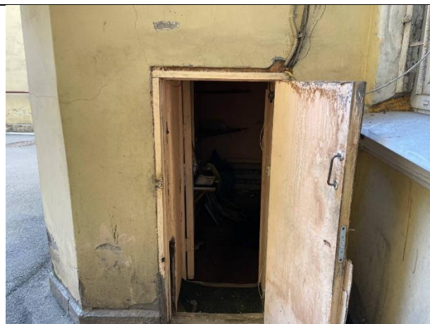
Фото № 8 – Вход в помещение со двора
