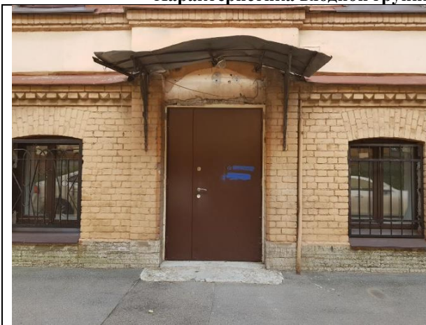
Фото 7. Общий вход с улицы (с торца)
