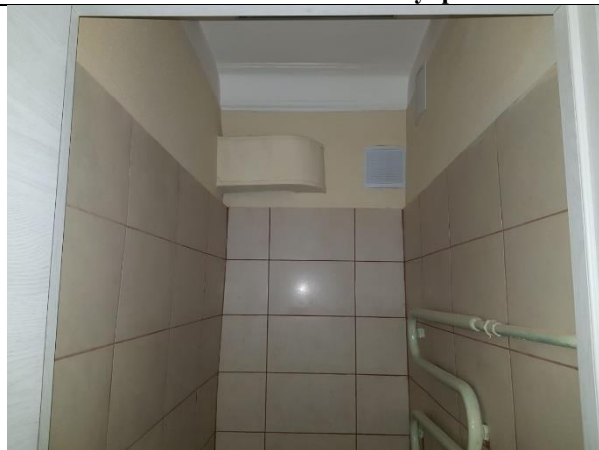
Фото 9. Внутреннее состояние Объекта оценки
