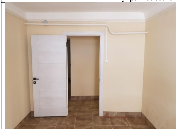
Фото 11. Внутреннее состояние Объекта оценки
