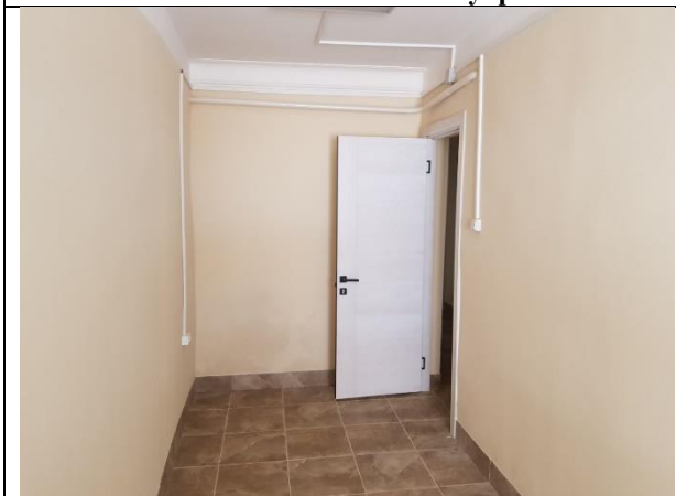
Фото 11. Внутреннее состояние Объекта оценки
