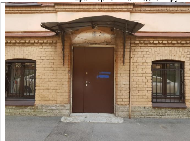
Фото 7. Общий вход с улицы (с торца)
