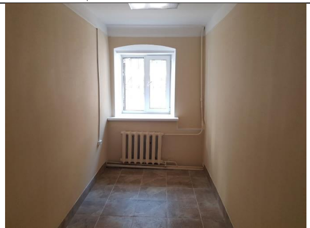
Фото 12. Внутреннее состояние Объекта оценки
