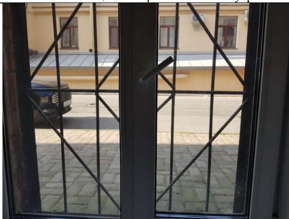
Фото 13. Внутреннее состояние Объекта оценки
