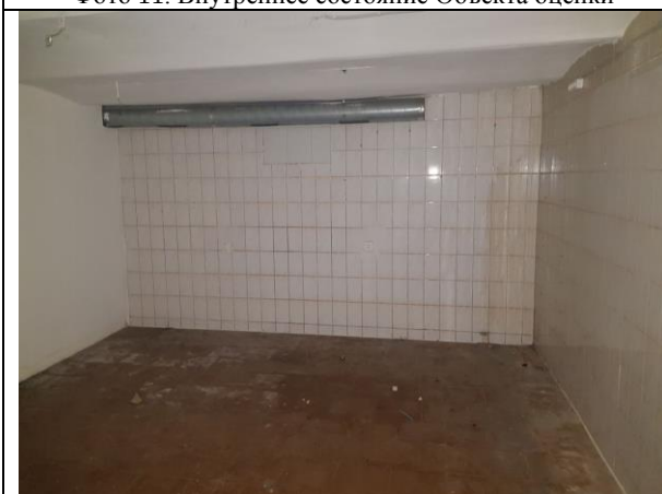
Фото 13. Внутреннее состояние Объекта оценки
