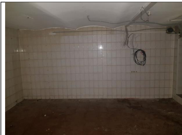
Фото 11. Внутреннее состояние Объекта оценки
