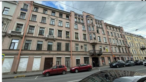
Фото 1. Вид здания, в котором расположен Объект оценки
