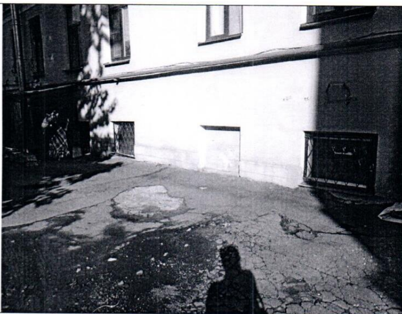
Описание: Вид Объекта снаружи
