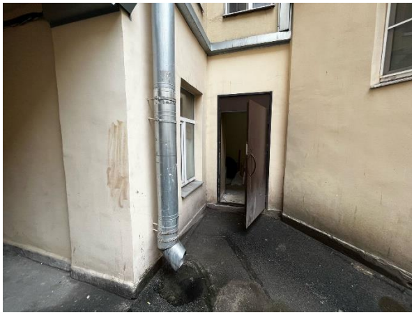
Фото 7. Вход со двора
