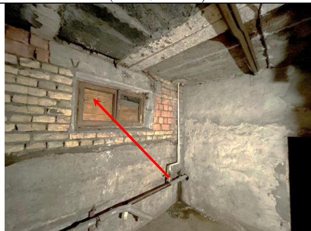
Фото 26. Оконная группа Объекта оценки (помещение 7-Н)
