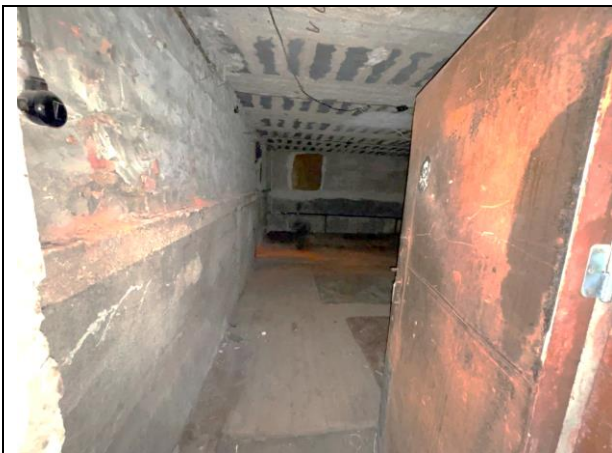
Фото 21. Типичное состояние Объекта оценки (помещение 7-Н)
