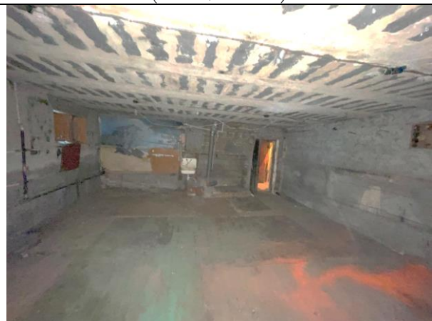
Фото 24. Типичное состояние Объекта оценки (помещение 7-Н)
