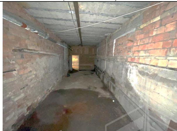
Фото 28. Типичное состояние Объекта оценки (помещение 7-Н)
