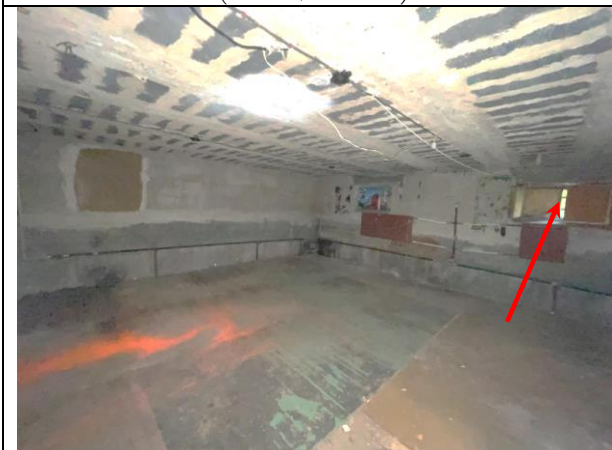
Фото 23. Оконная группа Объекта оценки (помещение 7-Н)
