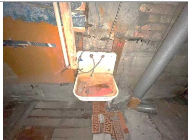
Фото 22. Типичное состояние Объекта оценки (помещение 7-Н)
