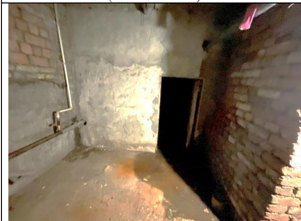
Фото 25. Типичное состояние Объекта оценки (помещение 7-Н)
