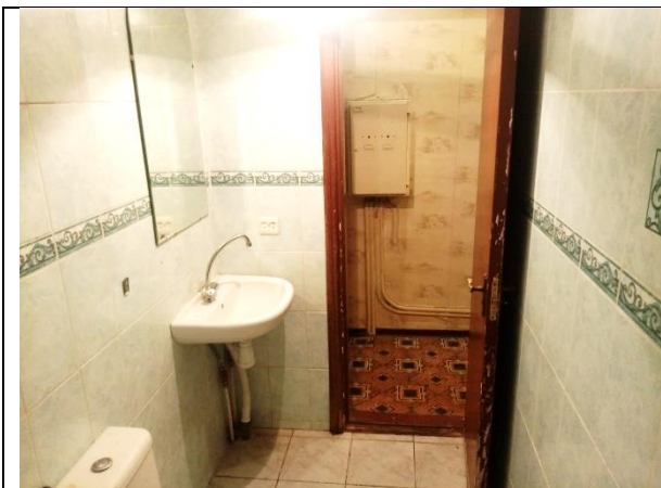
Фото 15. Внутреннее состояние Объекта оценки
