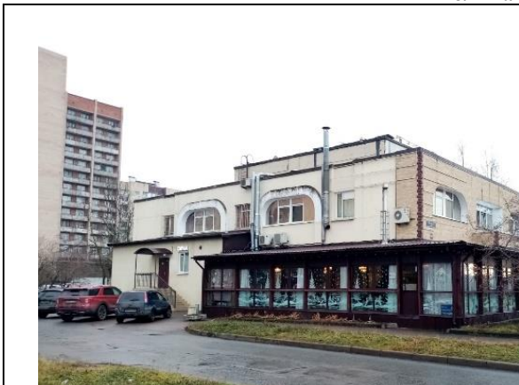
Фото 1. Вид здания, в котором расположен Объект оценки
