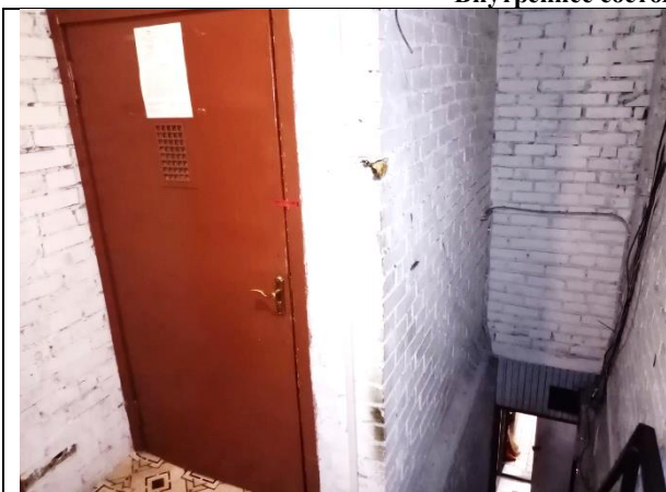
Фото 9. Внутреннее состояние Объекта оценки
