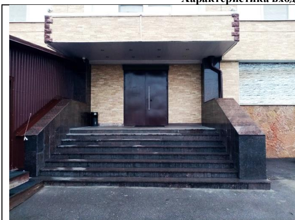
Фото 3. Общий вход с улицы
