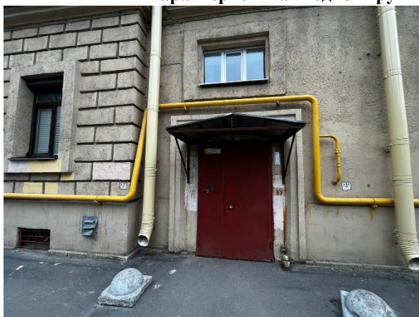
Фото 3. Общий вход со двора
