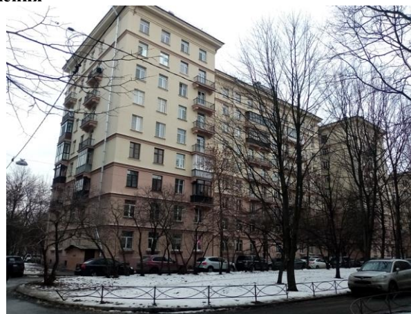
Фото 2. Вид здания, в котором расположен Объект оценки
