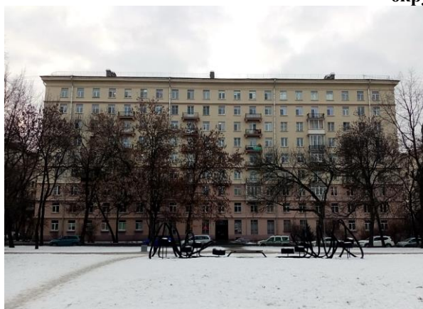
Фото 1. Вид здания, в котором расположен Объект оценки
