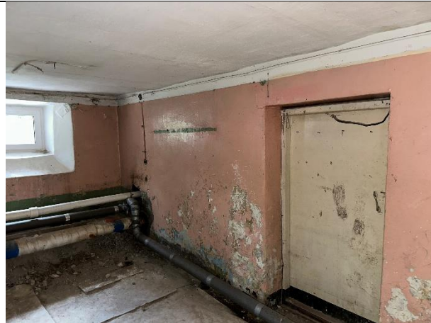
Фото № 17 – Внутреннее состояние помещения
