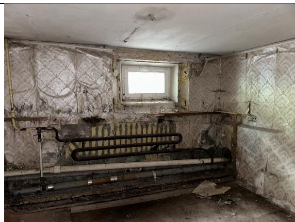
Фото № 12 – Внутреннее состояние помещения
