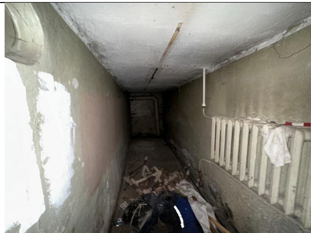
Фото № 24 – Внутреннее состояние помещения
