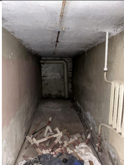
Фото № 8 – Внутреннее состояние помещения
