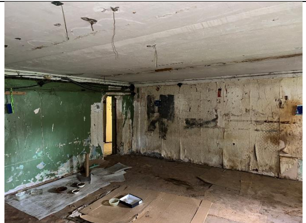
Фото № 22 – Внутреннее состояние помещения
