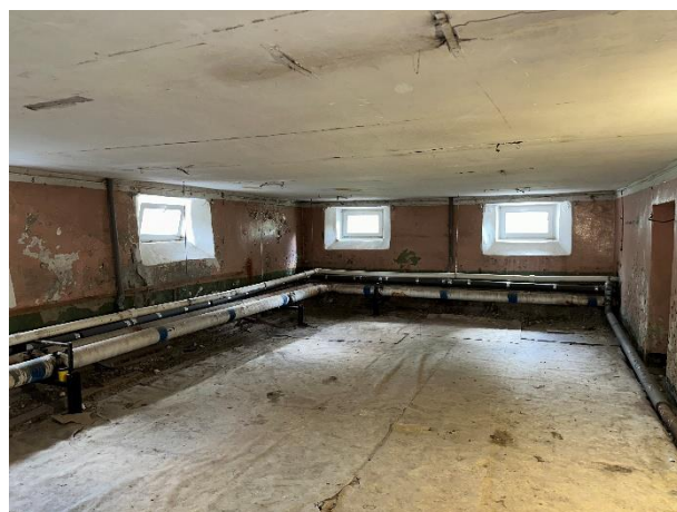
Фото № 16 – Внутреннее состояние помещения
