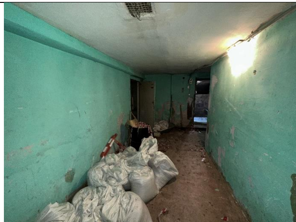
Фото № 23 – Внутреннее состояние помещения
