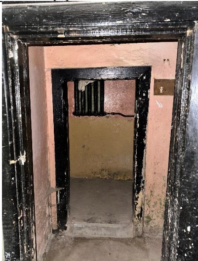
Фото № 9 – Внутреннее состояние помещения
