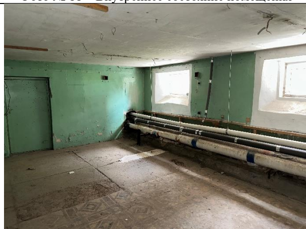
Фото № 13 – Внутреннее состояние помещения
