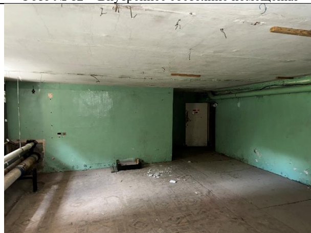
Фото № 14 – Внутреннее состояние помещения
