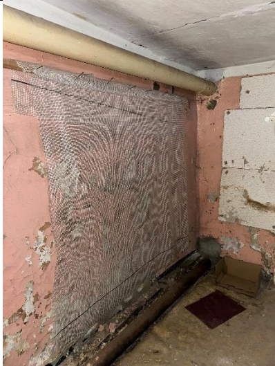
Фото № 19 – Внутреннее состояние помещения
