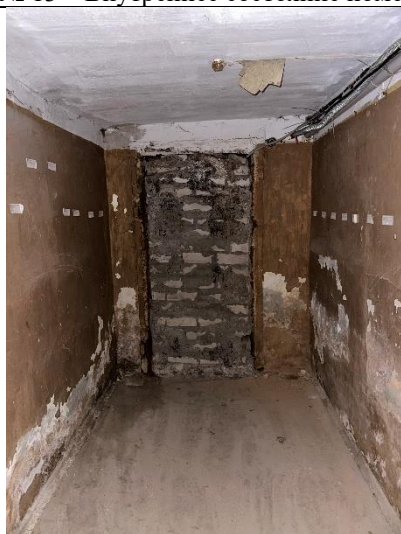
Фото № 15 – Внутреннее состояние помещения
