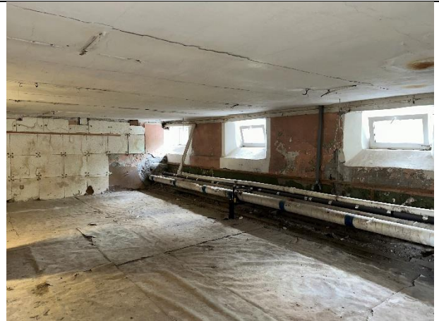
Фото № 18 – Общий вход в помещение
