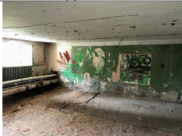
Фото № 21 – Внутреннее состояние помещения
