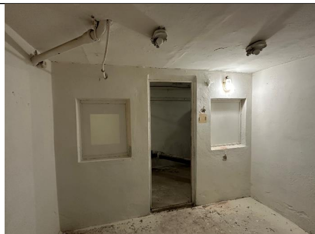
Фото № 14 – Внутреннее состояние помещения
