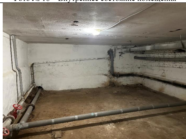
Фото № 18 – Внутреннее состояние помещения
