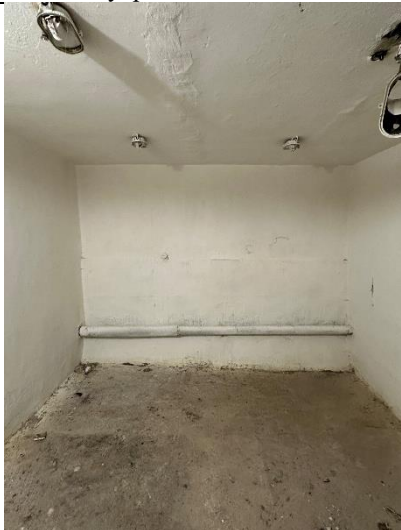
Фото № 11 – Внутреннее состояние помещения
