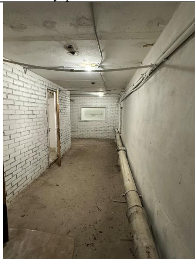
Фото № 10 – Внутреннее состояние помещения
