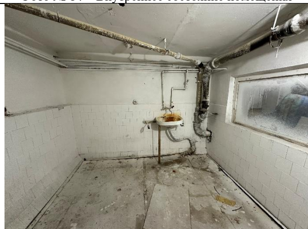
Фото № 16 – Внутреннее состояние помещения
