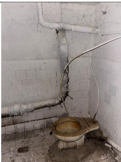
Фото № 19 – Внутреннее состояние помещения
