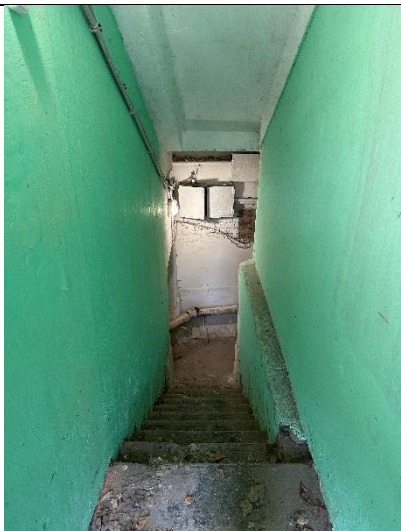
Фото № 7 – Внутреннее состояние помещения
