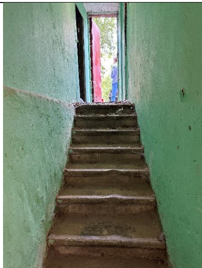
Фото № 8 – Внутреннее состояние помещения
