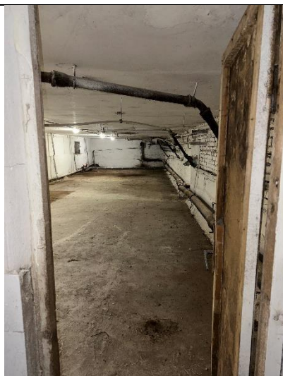
Фото № 20 – Внутреннее состояние помещения
