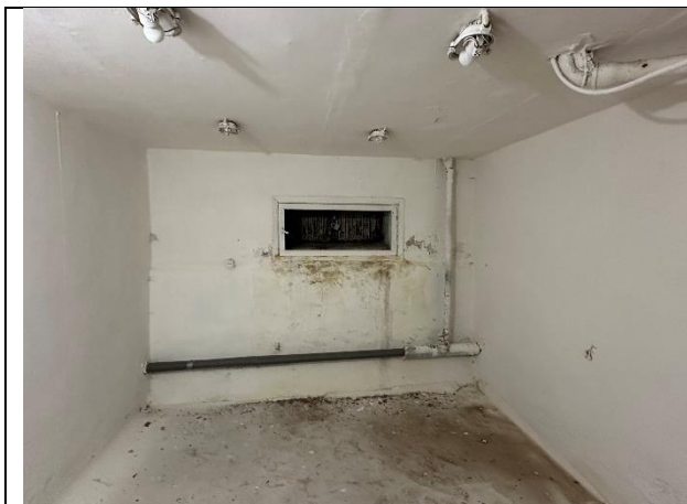
Фото № 13 – Внутреннее состояние помещения
