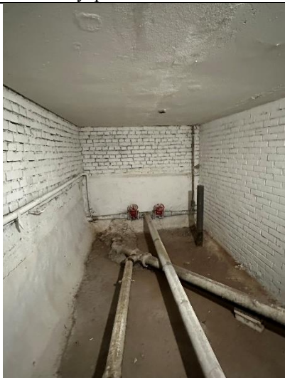
Фото № 9 – Внутреннее состояние помещения
