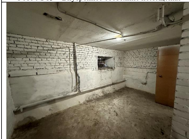
Фото № 15 – Внутреннее состояние помещения
