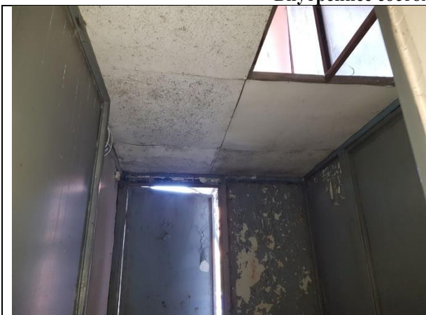
Фото 7. Внутреннее состояние Объекта оценки
