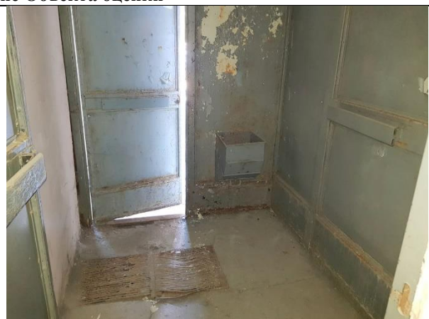
Фото 8. Внутреннее состояние Объекта оценки
