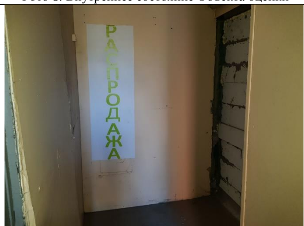
Фото 10. Внутреннее состояние Объекта оценки
