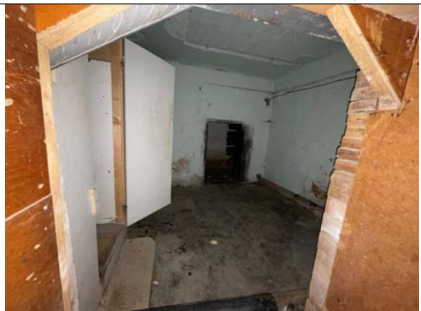
Фото 30. Типичное состояние Объекта оценки
