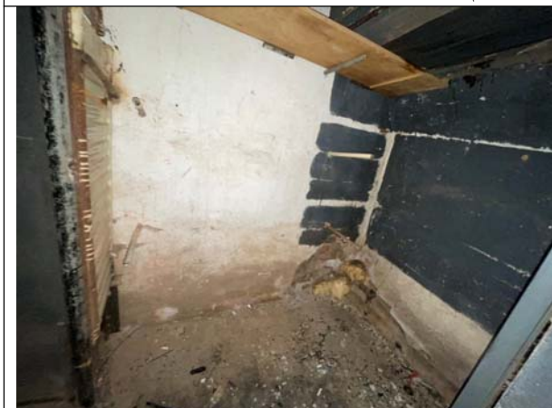
Фото 31. Типичное состояние Объекта оценки
