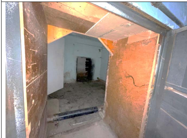
Фото 29. Типичное состояние Объекта оценки
