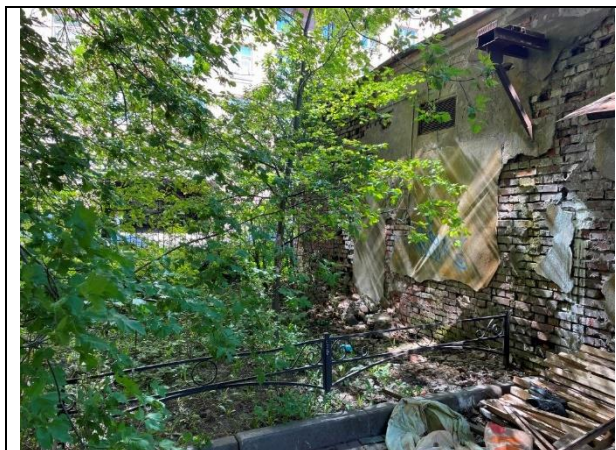
Фото 19. Вид здания расположения объекта оценки
