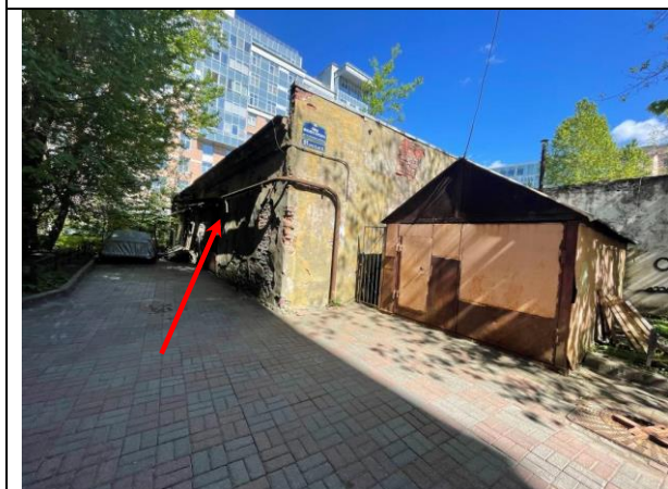
Фото 17. Вид здания расположения объекта оценки
