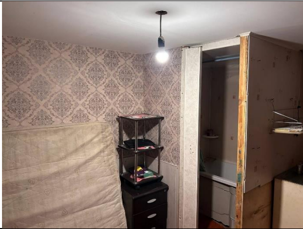
Фото № 13 – Внутреннее состояние помещения
