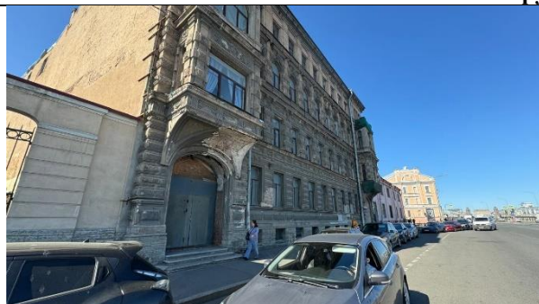
Фото 1. Вид здания, в котором расположен Объект оценки
