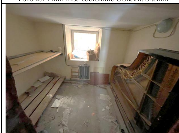
Фото 25. Типичное состояние Объекта оценки
