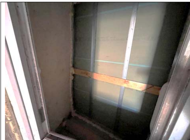
Фото 19. Типичное состояние Объекта оценки
