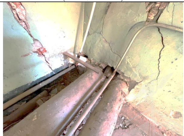
Фото 28. Типичное состояние Объекта оценки (помещение 17-Н)
