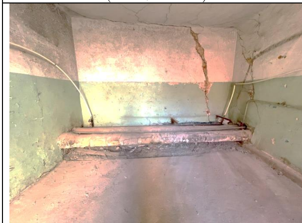
Фото 27. Типичное состояние Объекта оценки (помещение 17-Н)
