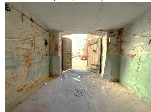
Фото 25. Типичное состояние Объекта оценки (помещение 17-Н)
