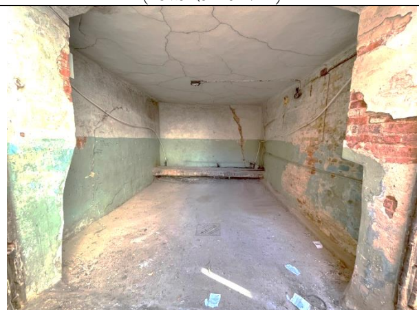
Фото 26. Типичное состояние Объекта оценки (помещение 17-Н)
