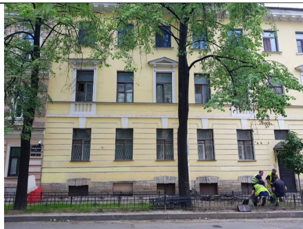
Фото 2. Вид здания, в котором расположен Объект оценки
