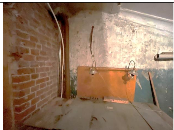
Фото 24. Типичное состояние Объекта оценки
