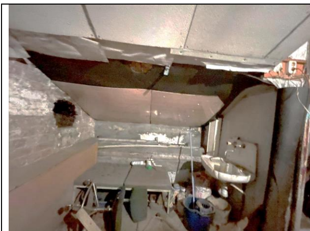
Фото 23. Типичное состояние Объекта оценки
