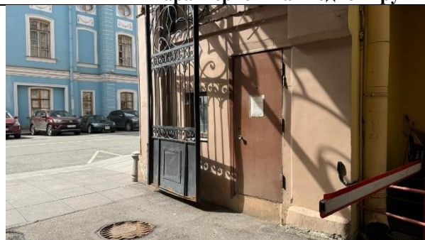
Фото 5. Отдельный вход и окно Объекта оценки
