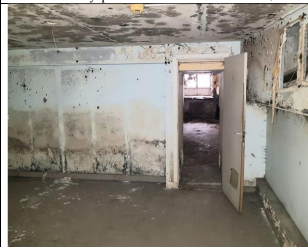
Фото 13. Внутреннее состояние Объекта оценки
