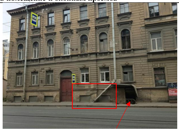
Фото 8. 1 отдельный вход с улицы, окна
