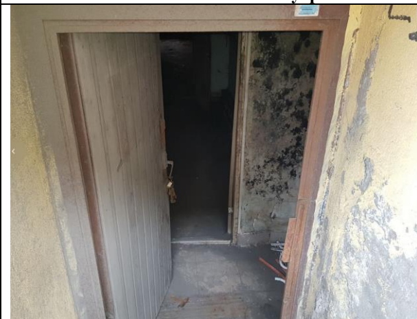
Фото 11. Внутреннее состояние Объекта оценки
