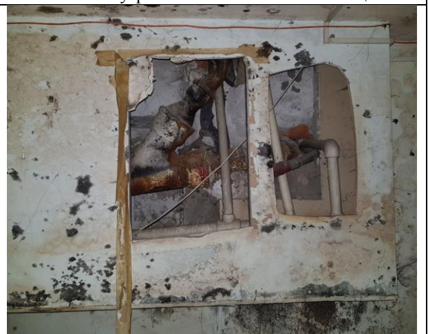
Фото 14. Внутреннее состояние Объекта оценки
