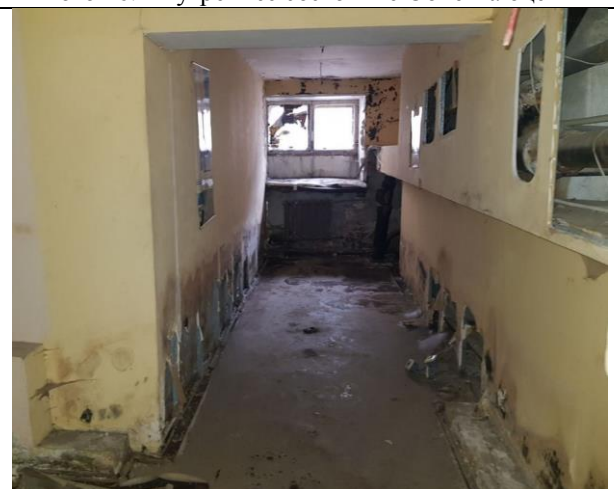
Фото 18. Внутреннее состояние Объекта оценки
