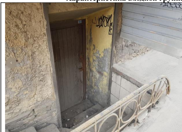
Фото 7. 1 отдельный вход с улицы
