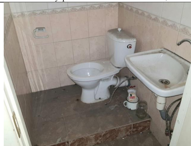
Фото 20. Внутреннее состояние Объекта оценки
