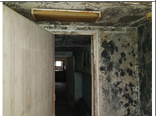
Фото 12. Внутреннее состояние Объекта оценки
