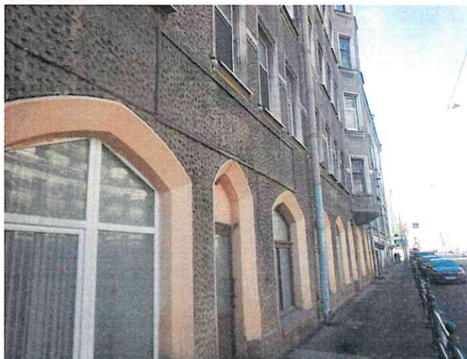
Фото №4 (вход в помещение)
