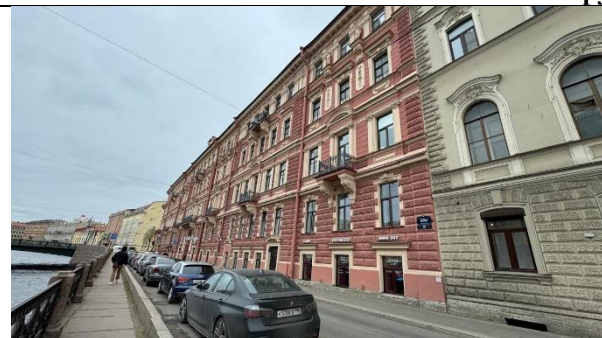
Фото 1. Вид здания, в котором расположен Объект оценки
