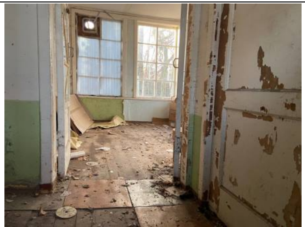
Фото № 10. Внутреннее состояние здание литеры Б
