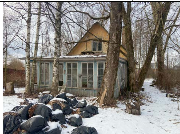
Фото № 6. Внешний вид здания литеры А
