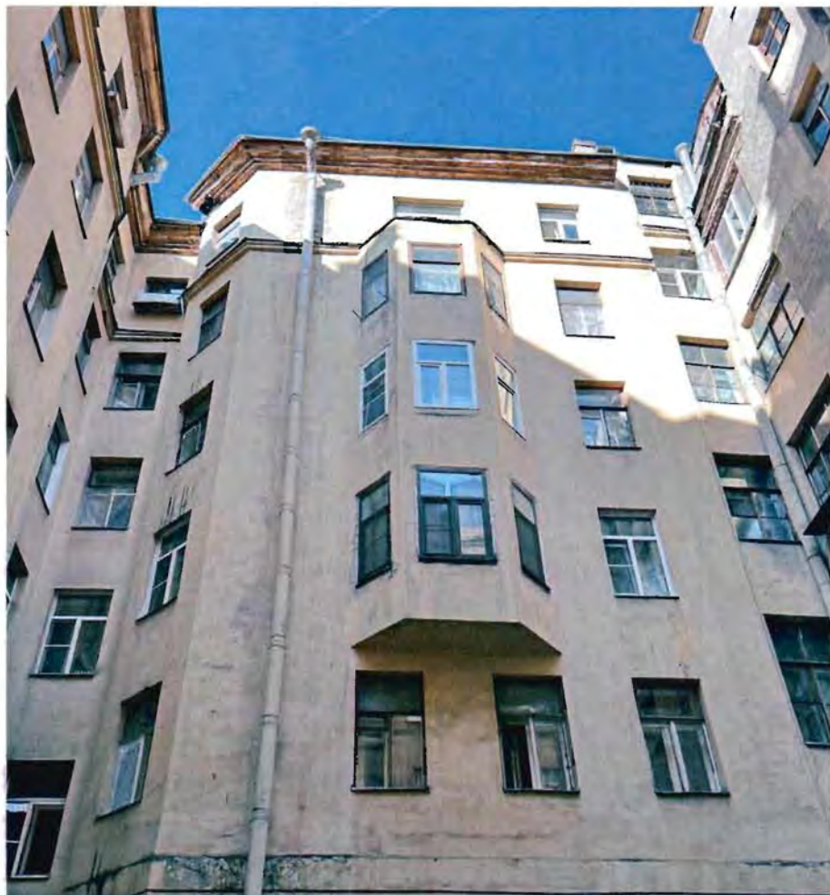
3. Дворовые фасады объекта культурного наследия.
