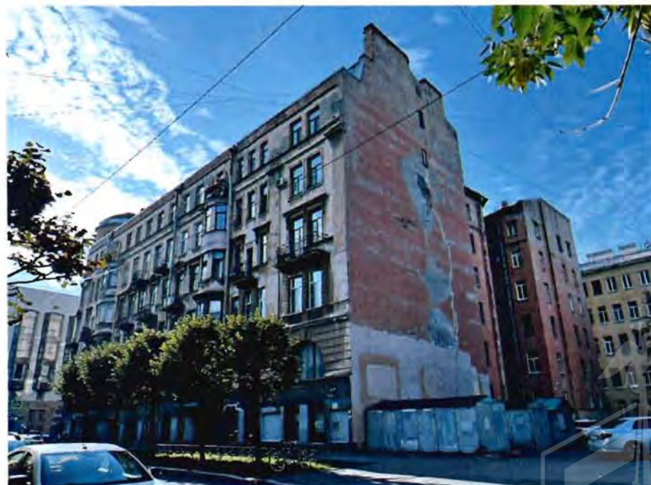
2. Общий вид на объект культурного наследия.
