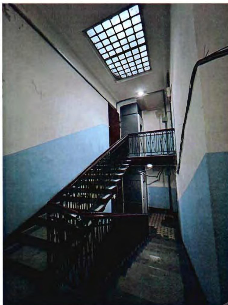
6. Лестница 1ЛК объекта культурного наследия.
