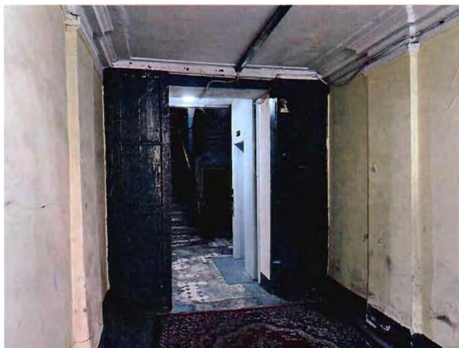
5. Помещение 1ЛК объекта культурного наследия.
