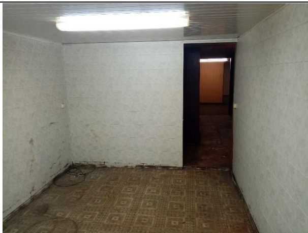
Фото № 17. Внутреннее состояние помещения
