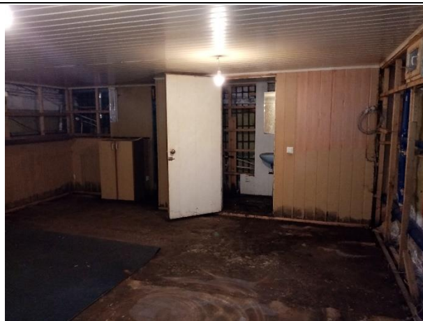
Фото № 10. Внутреннее состояние помещения
