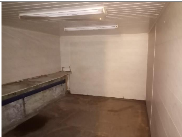
Фото № 19. Внутреннее состояние помещения
