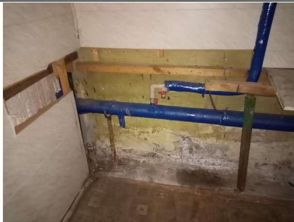
Фото № 21. Внутреннее состояние помещения
