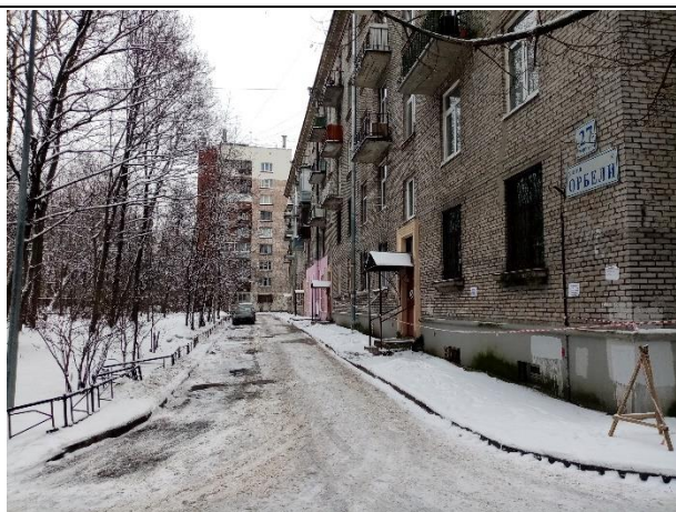
Фото № 1. Ближайшее окружение и подъездные пути
