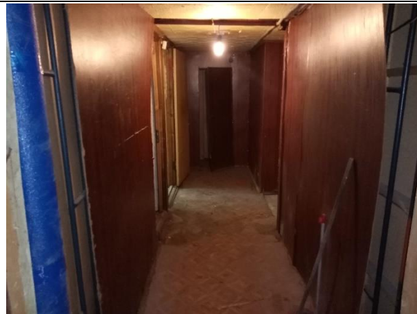
Фото № 22. Внутреннее состояние помещения
