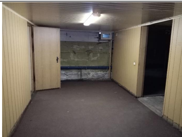
Фото № 16. Внутреннее состояние помещения
