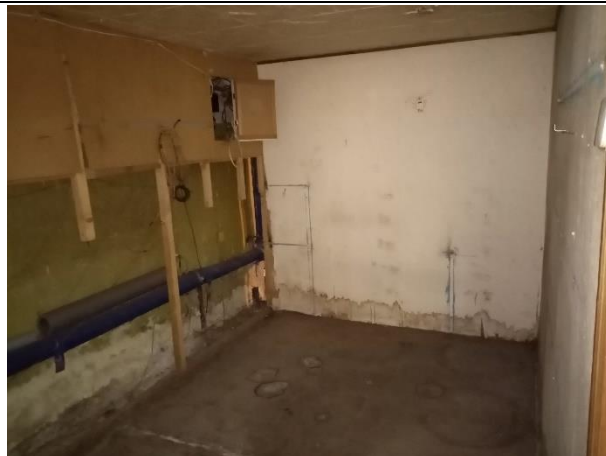
Фото № 14. Внутреннее состояние помещения
