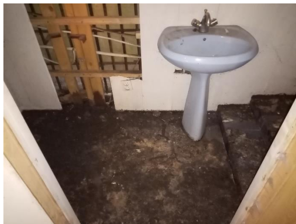
Фото № 12. Внутреннее состояние помещения
