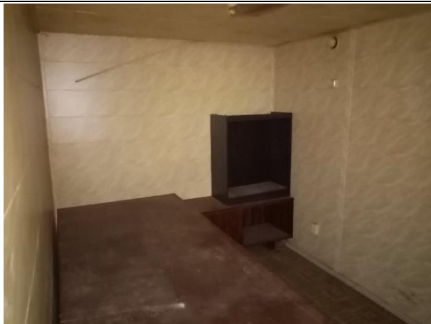
Фото № 13. Внутреннее состояние помещения
