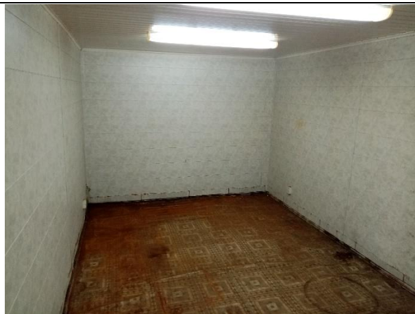
Фото № 18. Внутреннее состояние помещения
