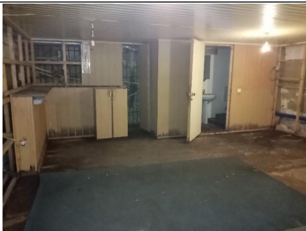
Фото № 9. Внутреннее состояние помещения
