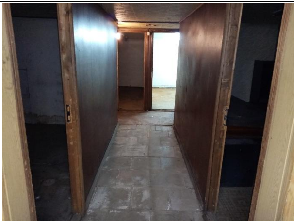
Фото № 15. Внутреннее состояние помещения
