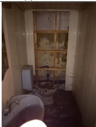
Фото № 11. Внутреннее состояние помещения
