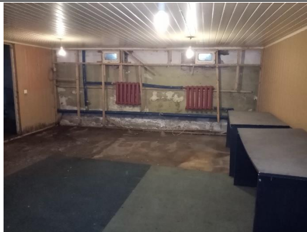
Фото № 8. Внутреннее состояние помещения
