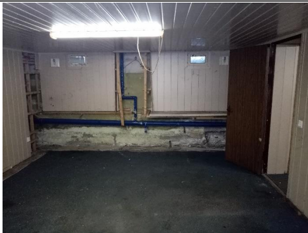
Фото № 7. Внутреннее состояние помещения
