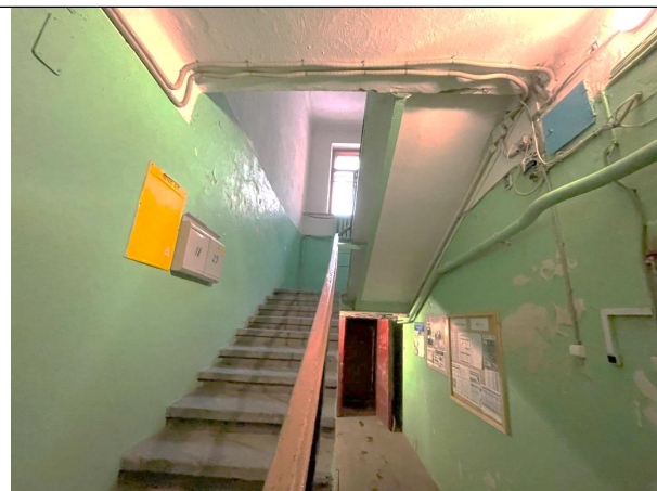
Фото 32. Лестничный проём Объекта оценки
