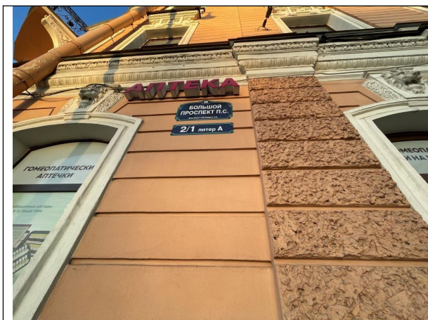
Фото 23. Адрес Объекта оценки
