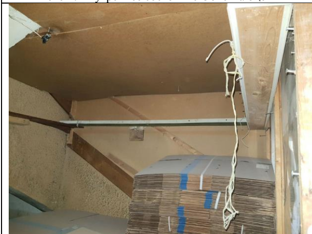
Фото 9. Внутреннее состояние Объекта оценки
