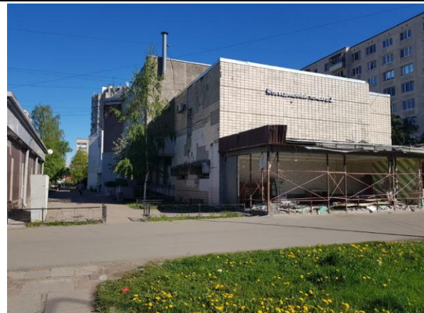
Фото 1. Вид здания, в котором расположен Объект оценки
