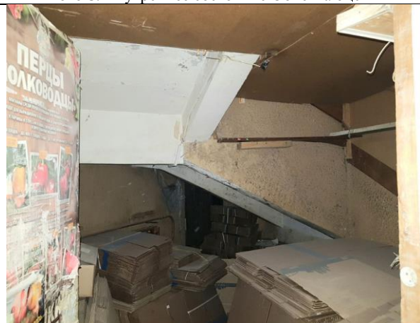
Фото 10. Внутреннее состояние Объекта оценки
