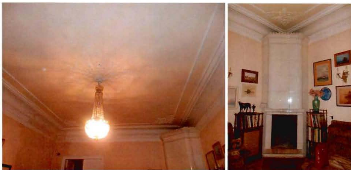
21, 22. Архитектурно-художественная отделка интерьеров квартир (кв. 26)
