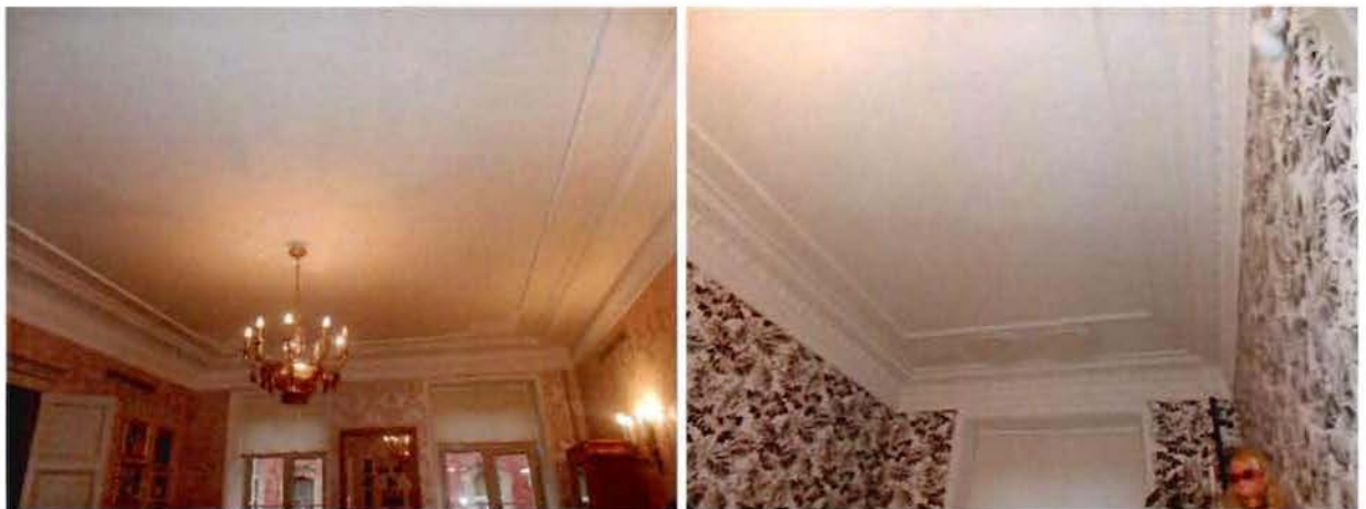
27, 28. Сводчатые потолки в уровне 1 этажа здания (кв. 24)
