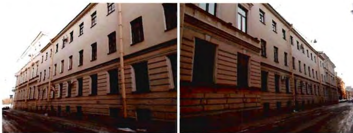
9, 10. Внутренний двор. Северный и южный фасады
