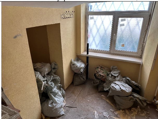
Фото № 17 – Внутреннее состояние помещения
