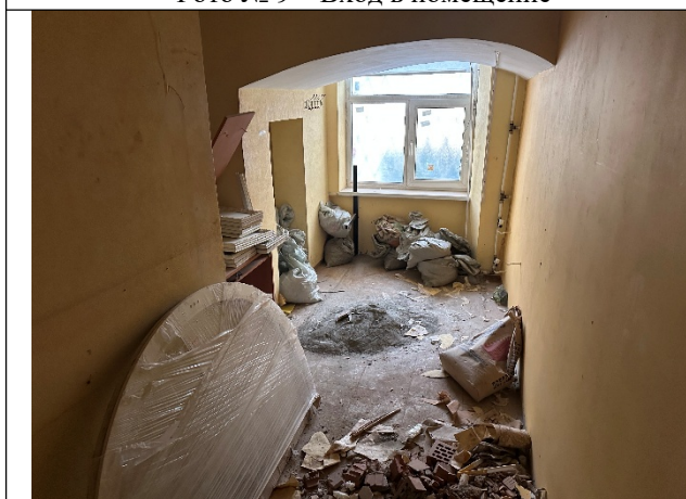
Фото № 11 – Внутреннее состояние помещения
