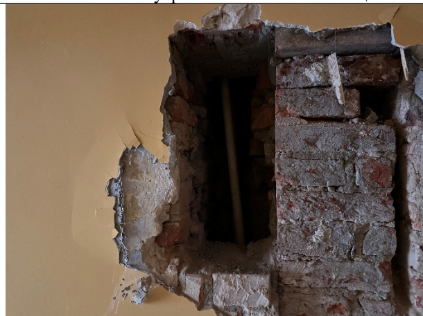
Фото № 18 – Внутреннее состояние помещения
