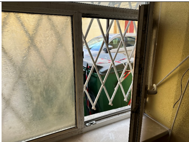
Фото № 15 – Внутреннее состояние помещения
