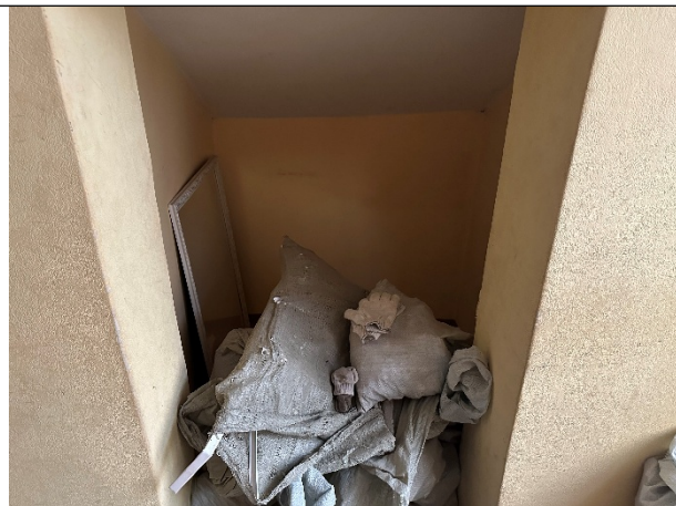
Фото № 16 – Внутреннее состояние помещения
