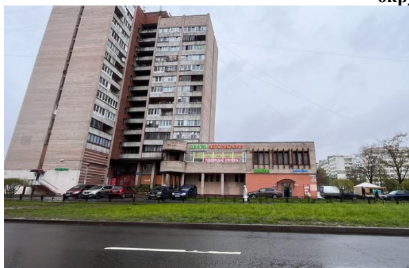
Фото 1. Вид здания Объекта оценки
