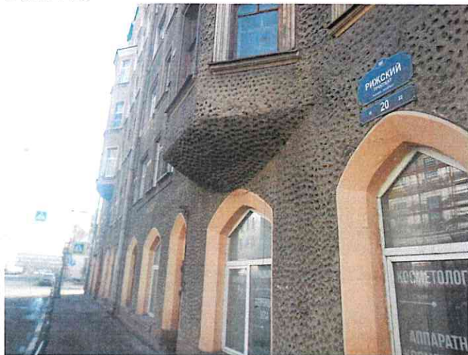
Фото №3 (вход в помещение)
