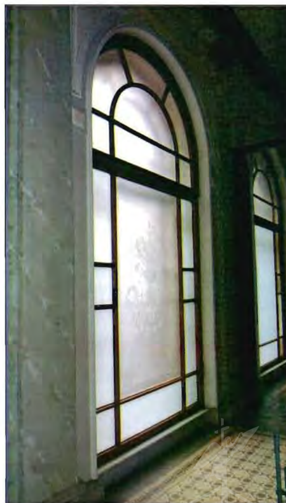
15. Интерьер. Фрагмент. Оконное заполнение.
