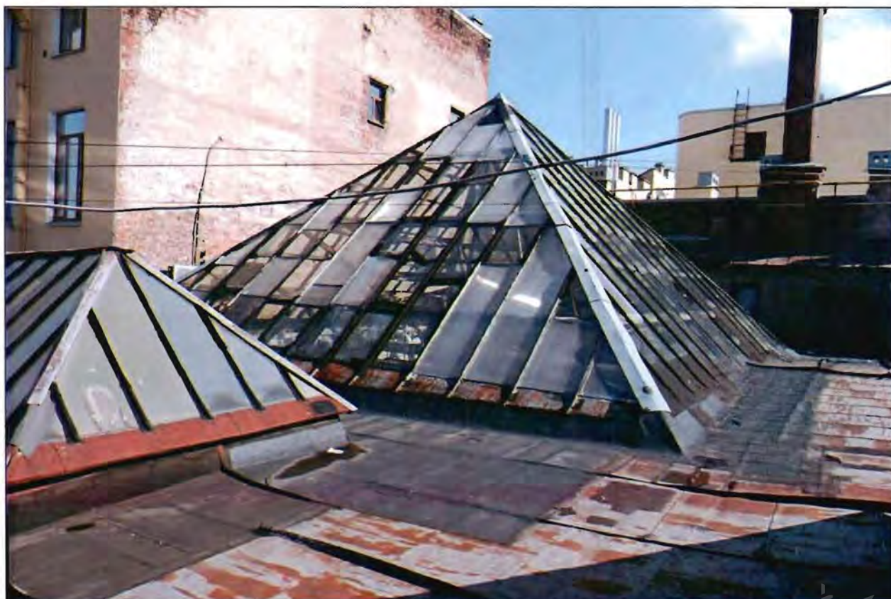
6. Общий вид кровли. Фрагмент. Световые фонари.
