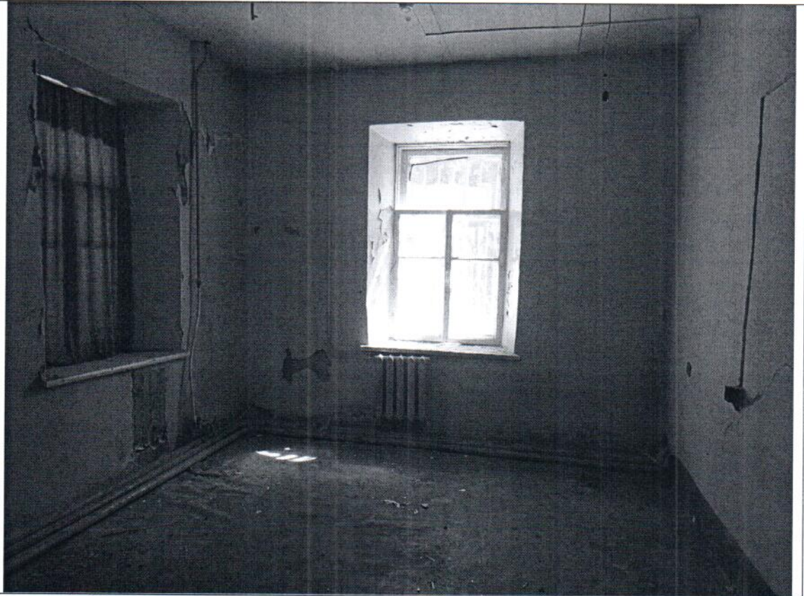
Описание вид ч.п. 7 Объекта
