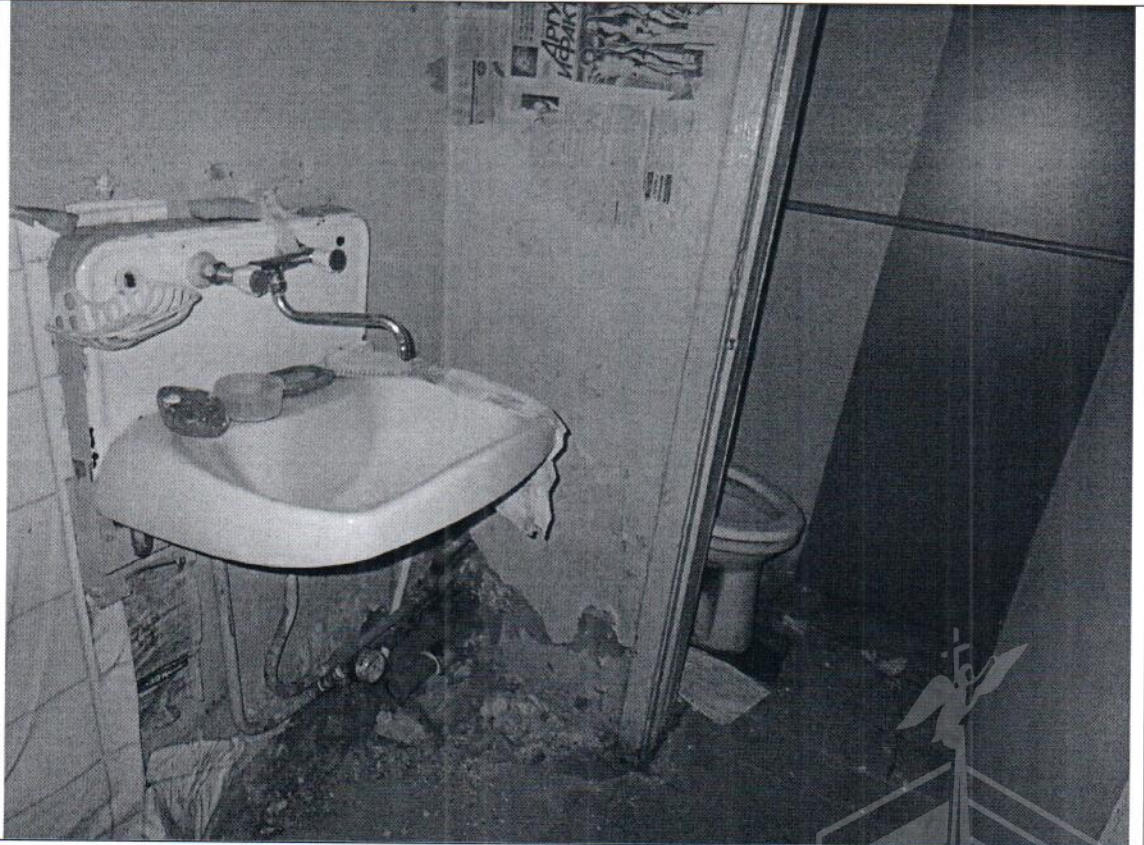
Описание вид ч.п. 4 Объекта
