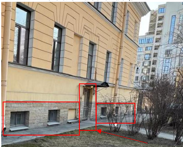
Фото 8. Общий вход с улицы Объекта оценки и окна
