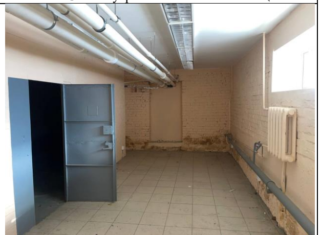
Фото № 34 – Внутреннее состояние помещения
