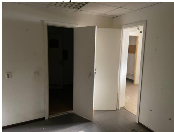
Фото № 18 – Вход в помещение
