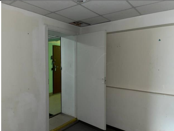
Фото № 21 – Внутреннее состояние помещения
