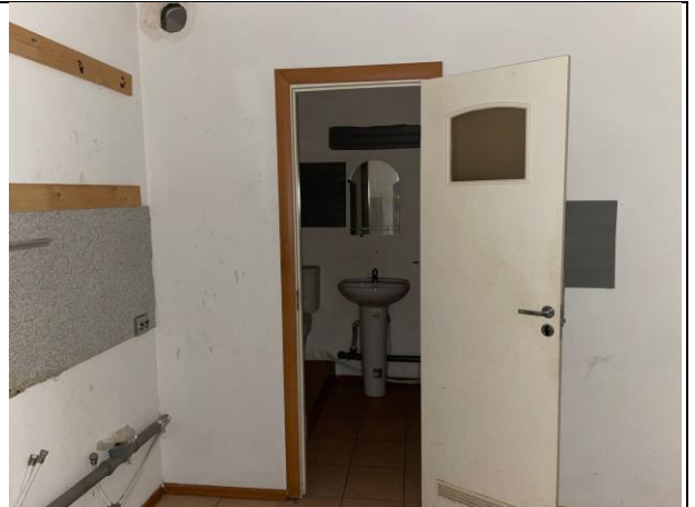
Фото № 22 – Внутреннее состояние помещения
