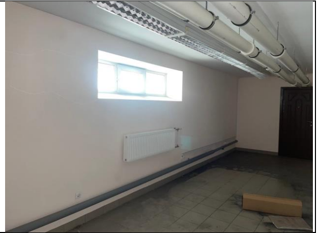
Фото № 30 – Внутреннее состояние помещения
