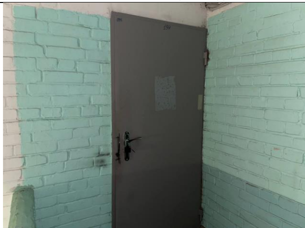
Фото № 11 – Вход в помещение
