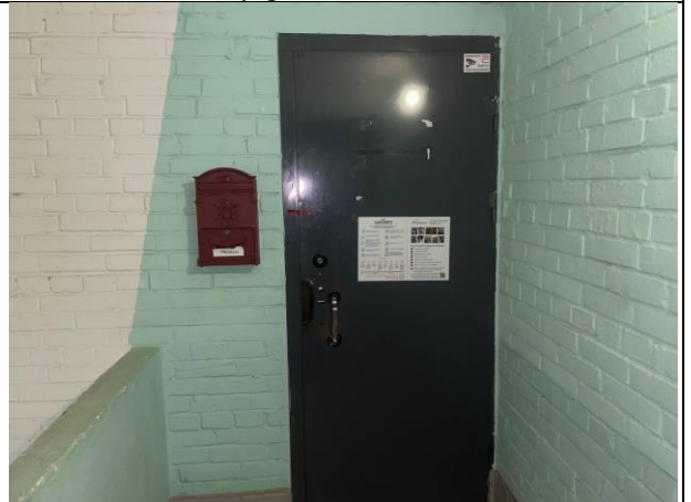
Фото № 24 – Вход в помещение
