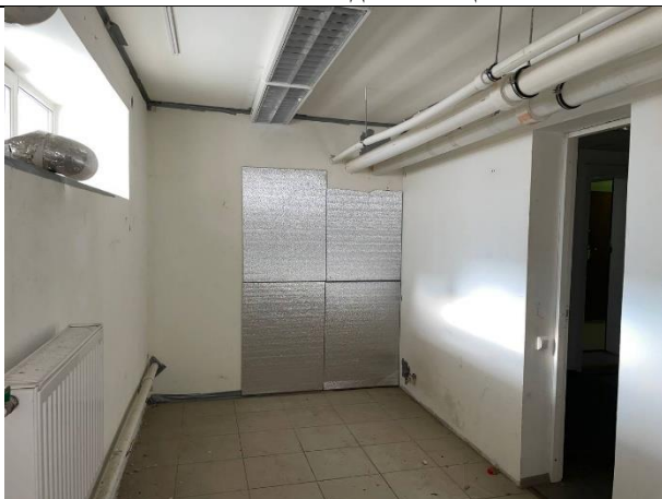
Фото № 19 – Внутреннее состояние помещения
