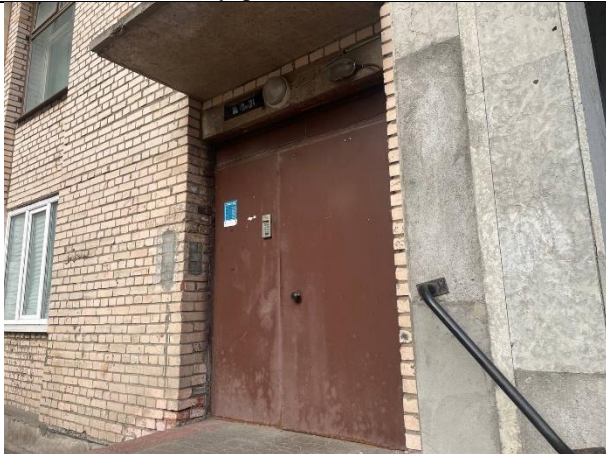
Фото № 23 – Общий вход
