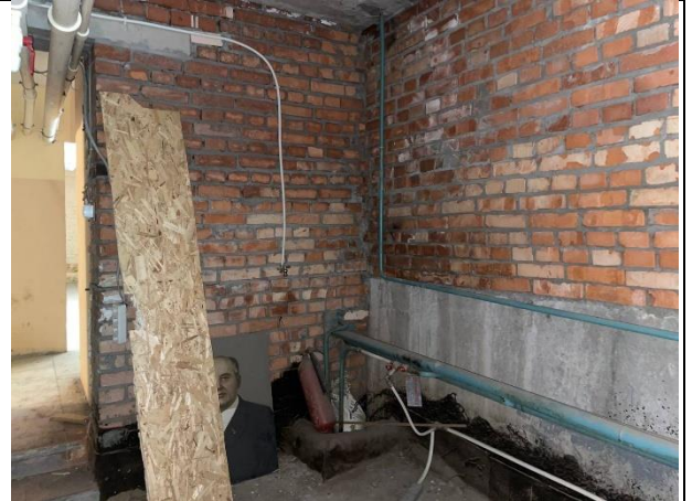
Фото № 32 – Внутреннее состояние помещения
