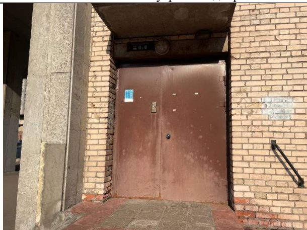
Фото № 9 – Общий вход
