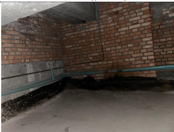
Фото № 33 – Внутреннее состояние помещения
