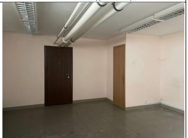
Фото № 26 – Внутреннее состояние помещения
