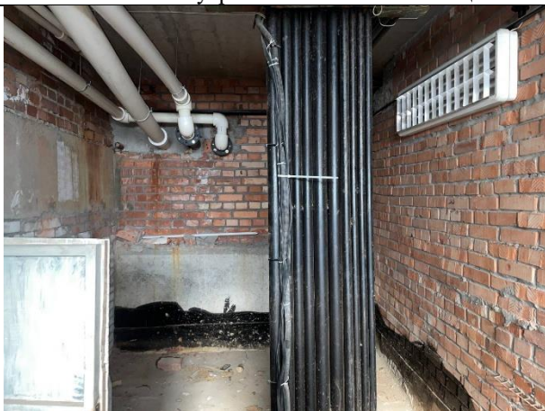
Фото № 35 – Внутреннее состояние помещения
