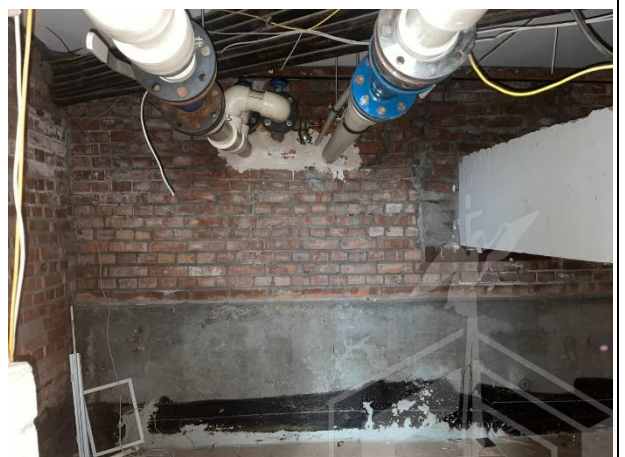
Фото № 28 – Внутреннее состояние помещения
