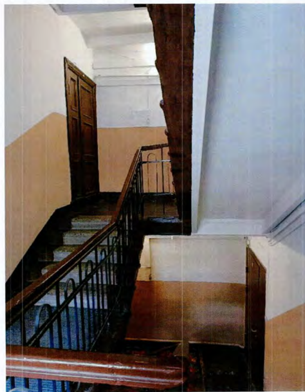
10. Двухмаршевая лестница в северном дворовом корпусе.
