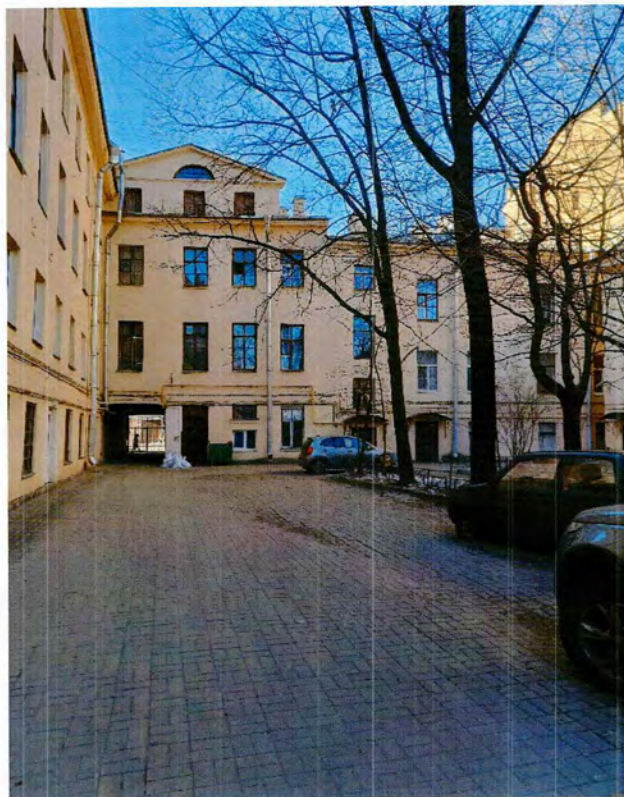
4. Вид на дворовой фасад лицевого корпуса объекта культурного наследия.
