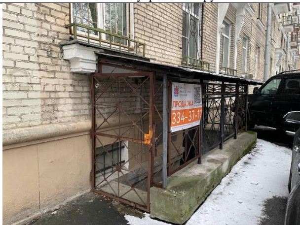
Фото № 9 – Вход в помещение со двора
