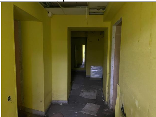
Фото № 25 – Внутреннее состояние помещения
