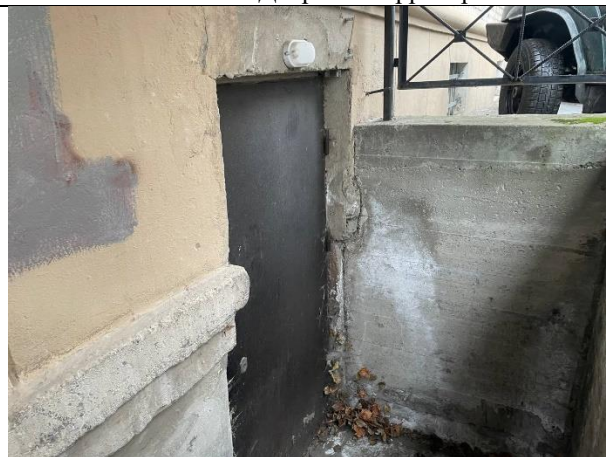
Фото № 10 – Вход в помещение со двора
