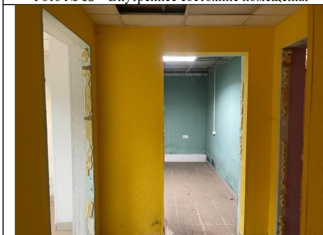
Фото № 17 – Внутреннее состояние помещения
