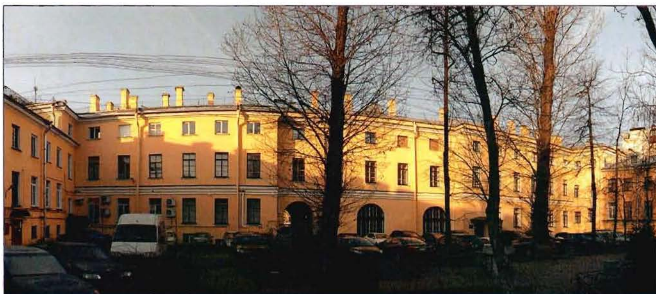
2. Дворовые фасады. Вид с юго-востока.
