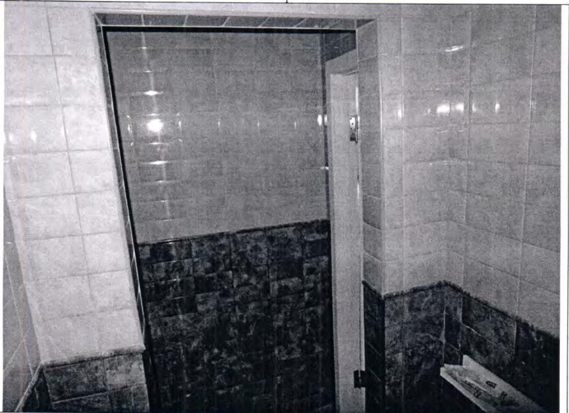
Описание: дверной проем между ч.п. 15 и 17 пом. 1-Н Объекта переоборудован в проем без дверного блока
