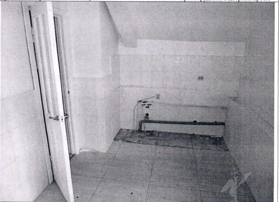
Описание: проем без дверного блока между ч.п. 10 и 12 пом. 1-Н Объекта переоборудован в дверной проем
