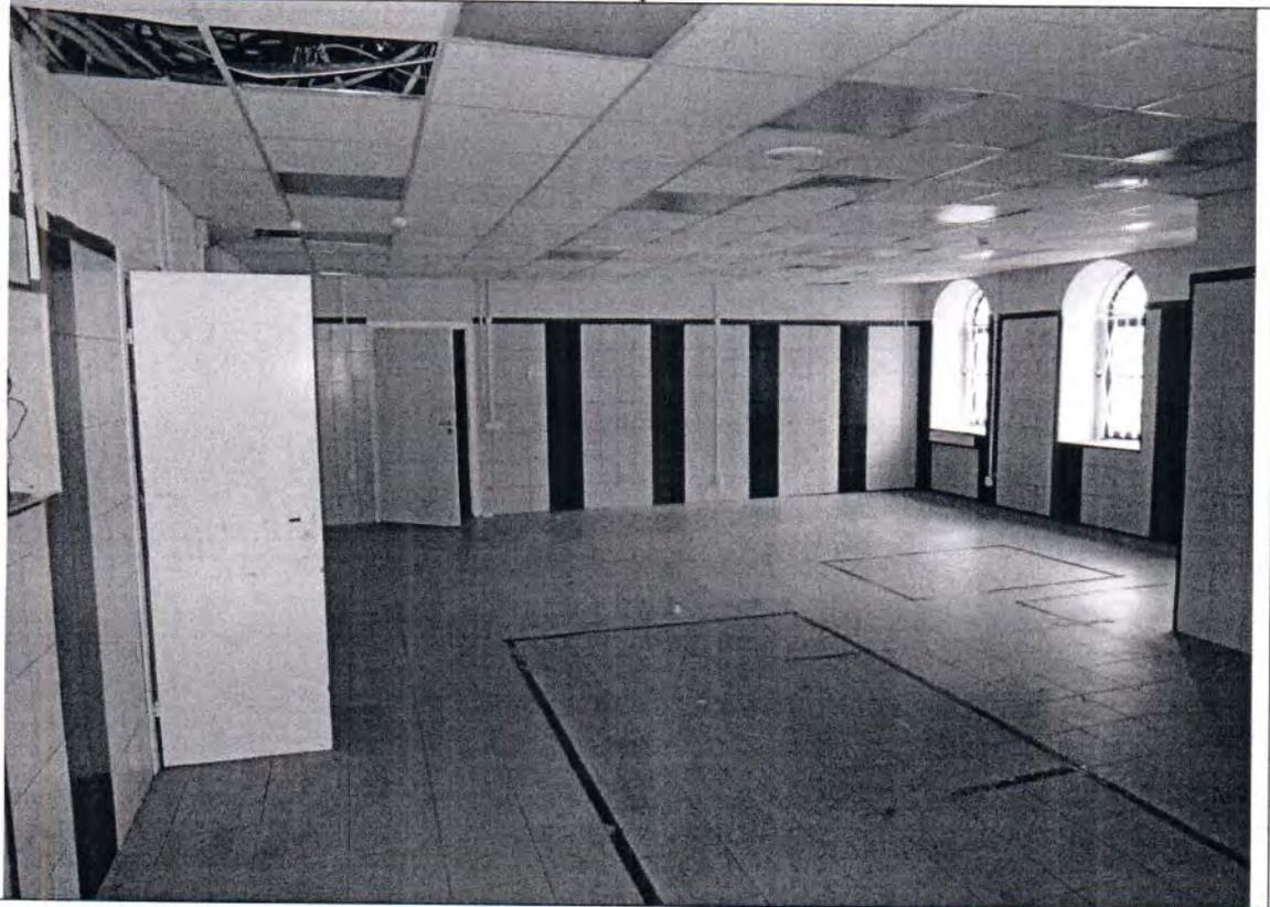
Описание: между ч.п. 1 и 9 пом. 1-Н Объекта демонтирована перегородка с проемами без дверных блоков, в ч.п. 1 пом. 1-Н Объекта возведена перегородка с дверным проемом
