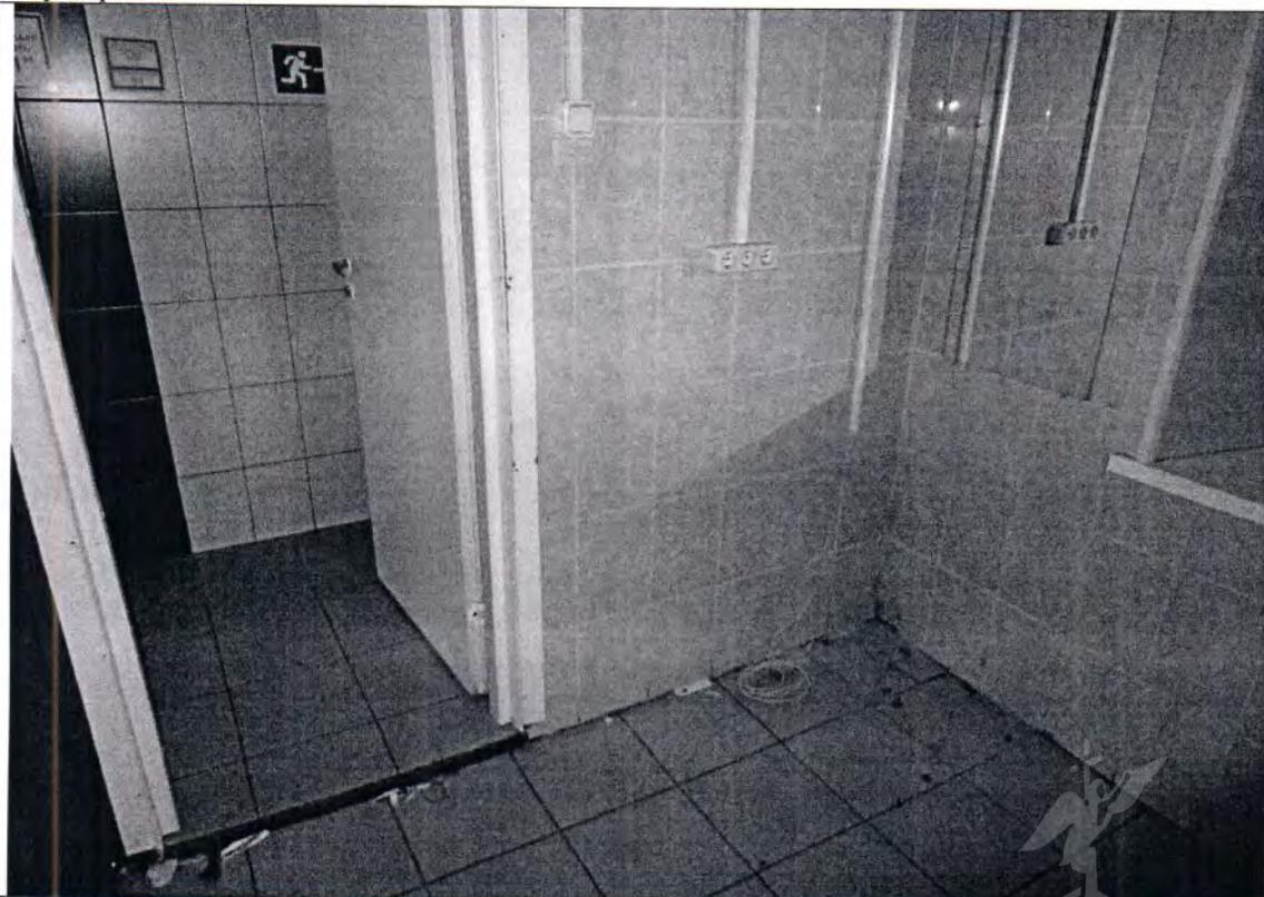
Описание: между ч.п. 4 и 5 пом. 1-Н Объекта оборудован дверной проем, в ч.п. 5 пом. 1-Н Объекта демонтировано сантехническое оборудование (две раковины)
