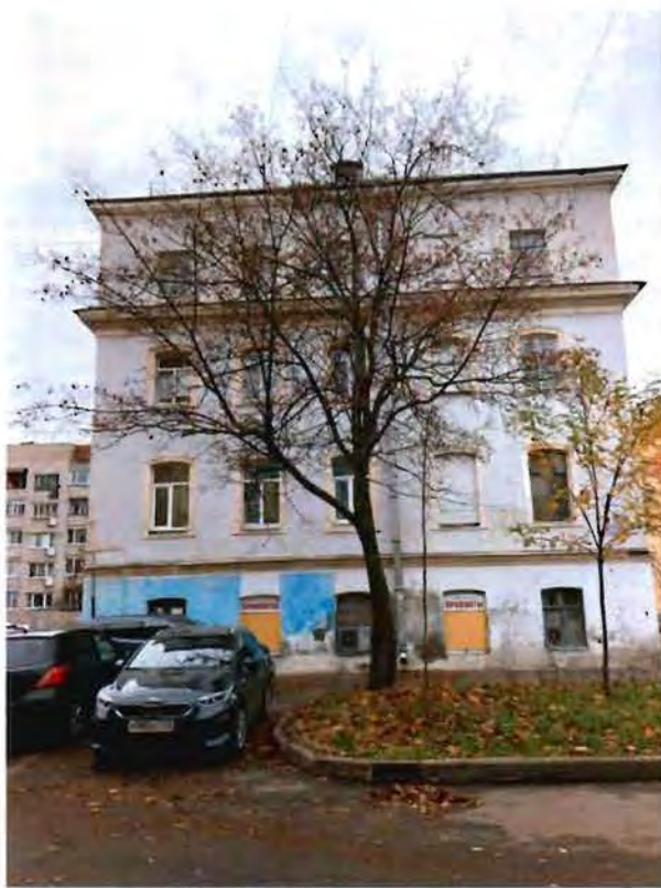
7. Южный фасад объекта культурного наследия.
