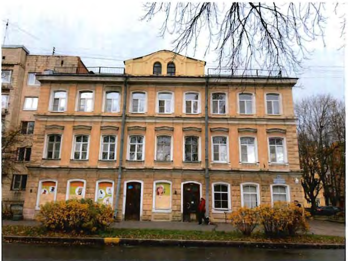
1. Южный фасад объекта культурного наследия.
